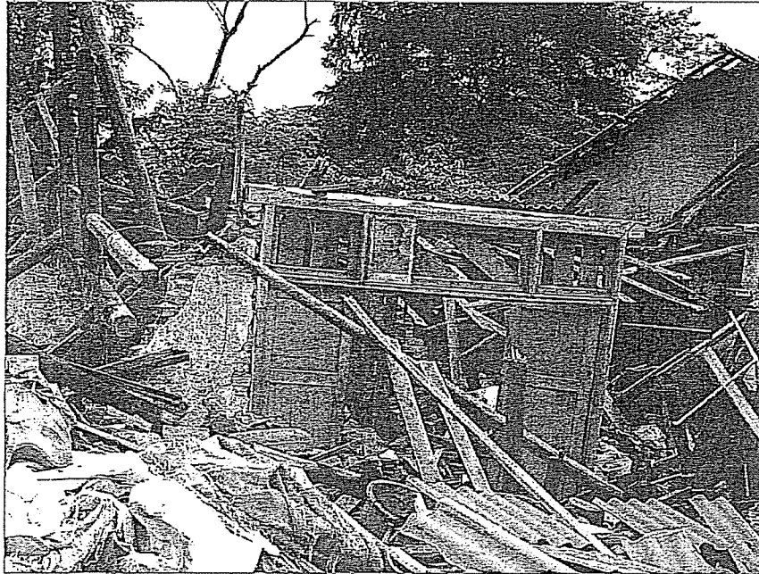
圖 1 自然災害造成的破壞
